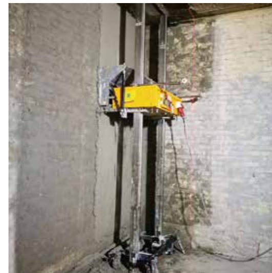
右图：自动粉墙机在工作中@李惟拉
