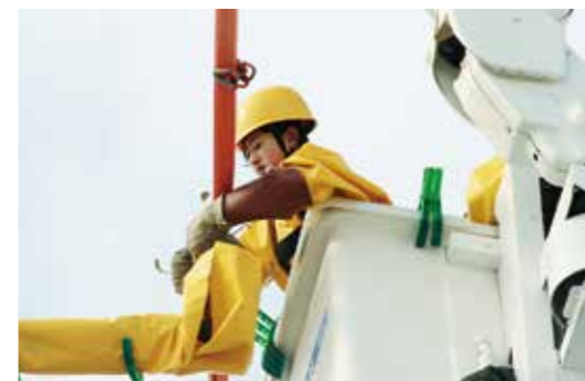
右图：她身穿14斤重的绝缘服，手握万伏高压的各种电线，在带电操作
