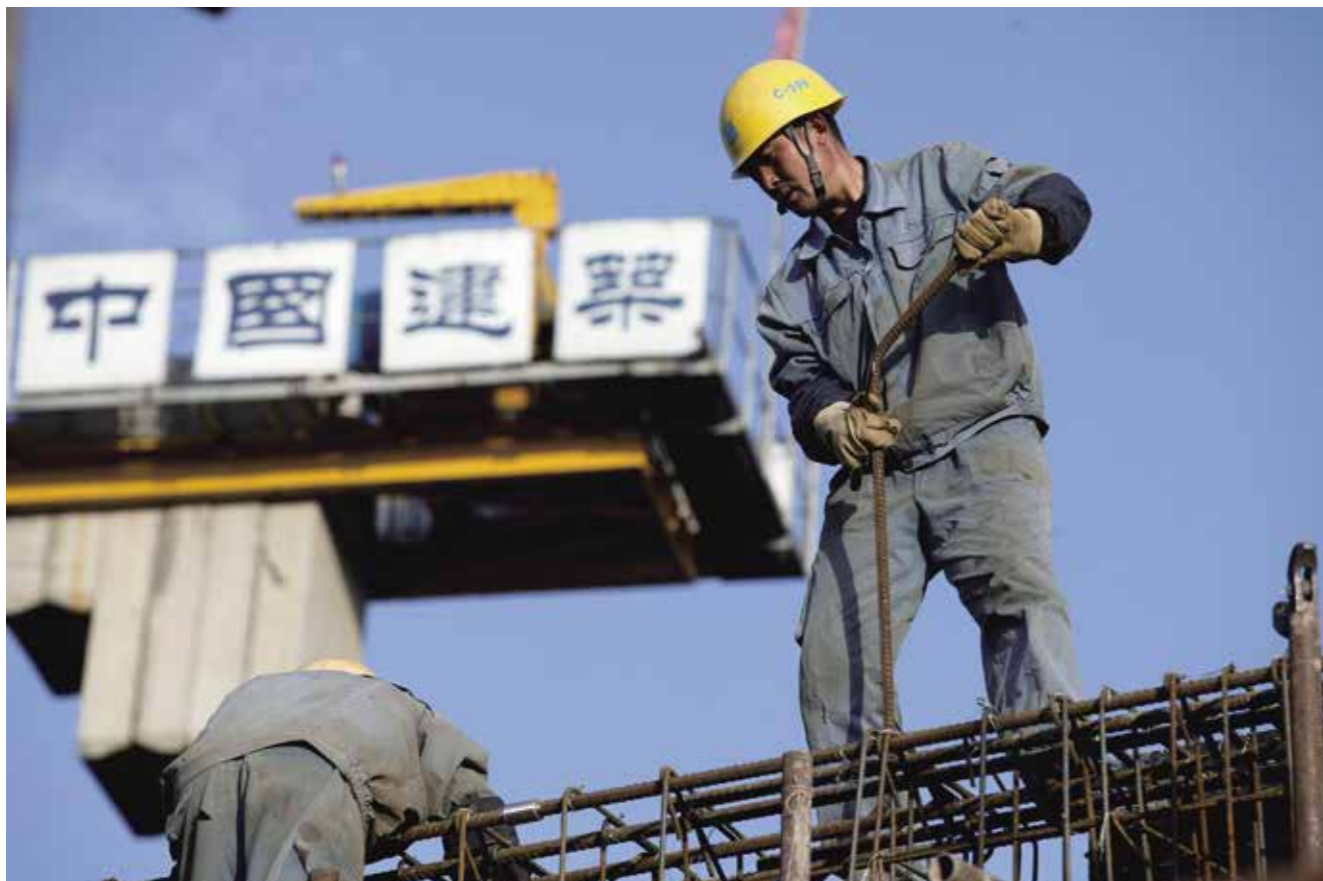
埃塞俄比亚阿迪斯阿贝巴，中国建筑工人正在建设的非洲联盟大厦
