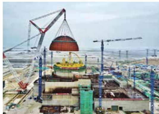
2017 年 5 月 25 日下午 5 时 58 分，福建福清，中国自主三代核电“华龙一号”全球首堆示范工程——中核集团福清核电 5 号机组穹顶吊装成功
