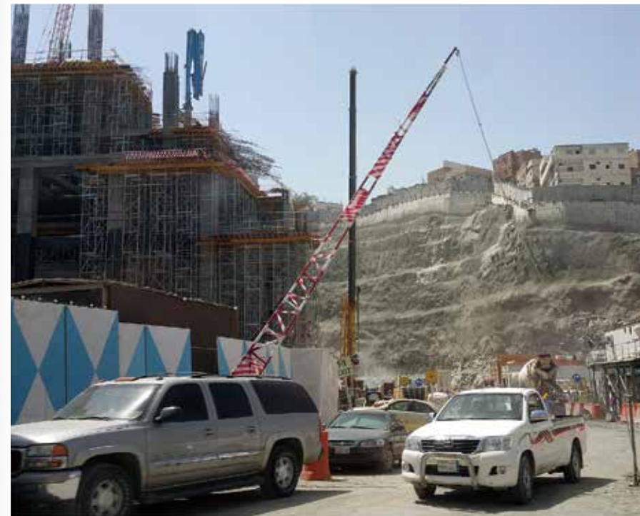
在沙特，随处可见忙碌的施工工地
